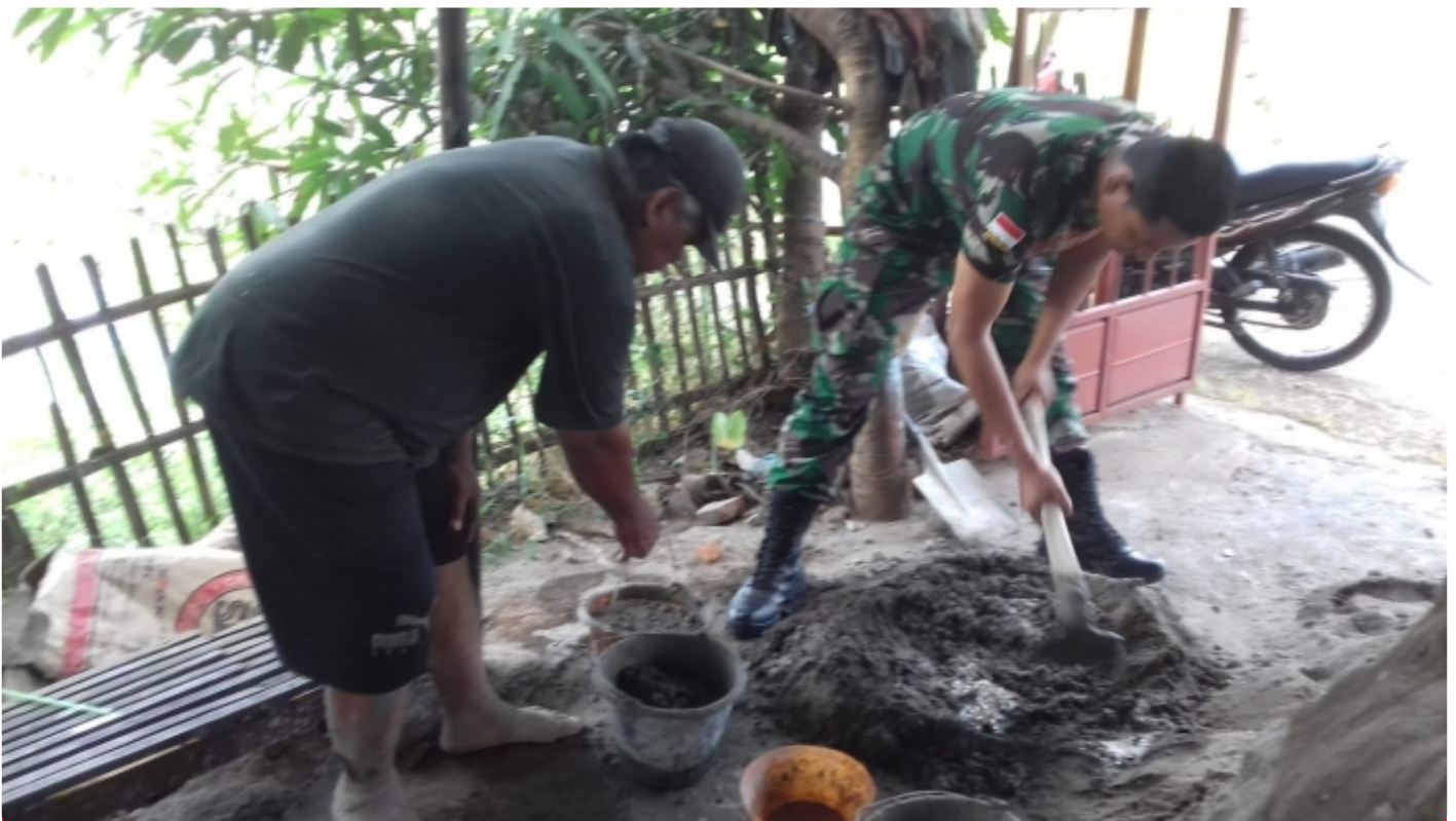
Babinsa Ceper Bantu Warga Renovasi Rumah Binaannya
