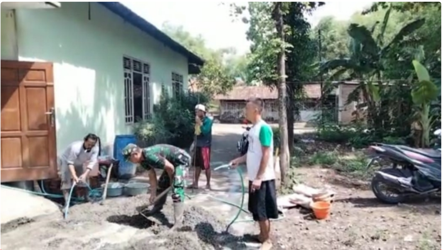
Bantu Kesulitan Warga Babinsa Ceper Cor Lantai Rumah Warga
